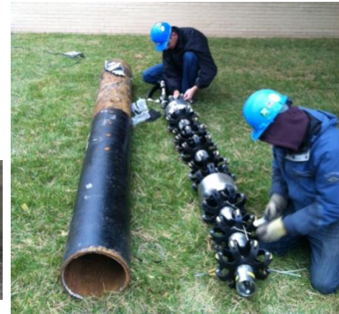
Afbeelding3. In-line inspectie met de See Snake van het bedrijf PICA
