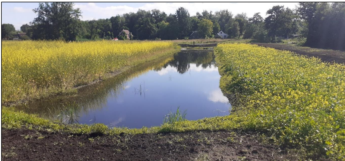
Afbeelding 3. IJzerzandfilter enkele maanden na aanleg (zomer 2022)
