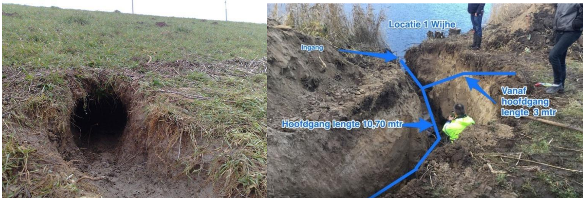
Afbeelding 2. Links: beverhol in waterkering, gegraven tijdens hoogwater en na het hoogwater zichtbaar [5]. Rechts: Voorbeeld van uitgegraven gangenstelsel van een beverfamilie [6]
