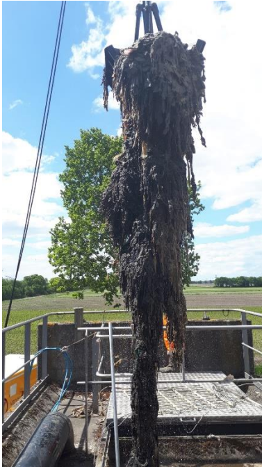
Afbeelding 3. Vervuiling bij een rioolgemaal (Bron: Waterschap Brabantse Delta)
